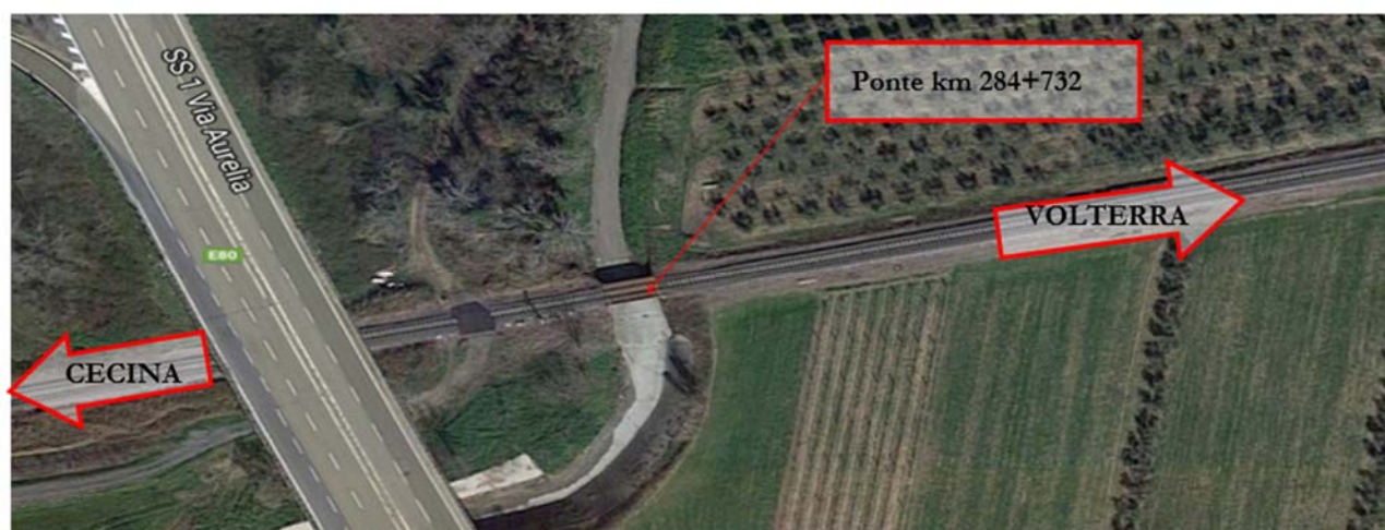
Figura 1.1 Vista satellitare del ponte
