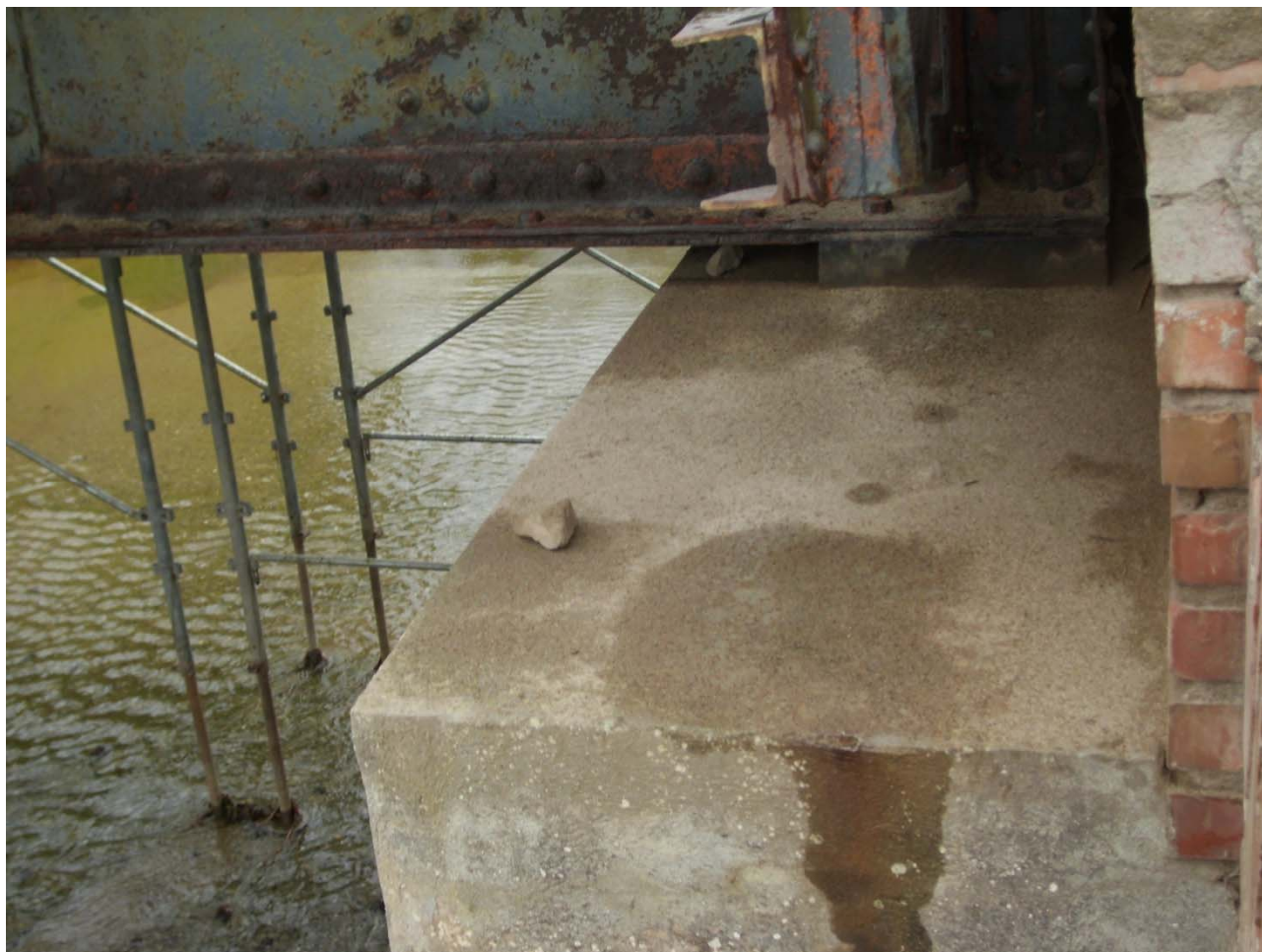
Figura 3 - Particolare appoggio
