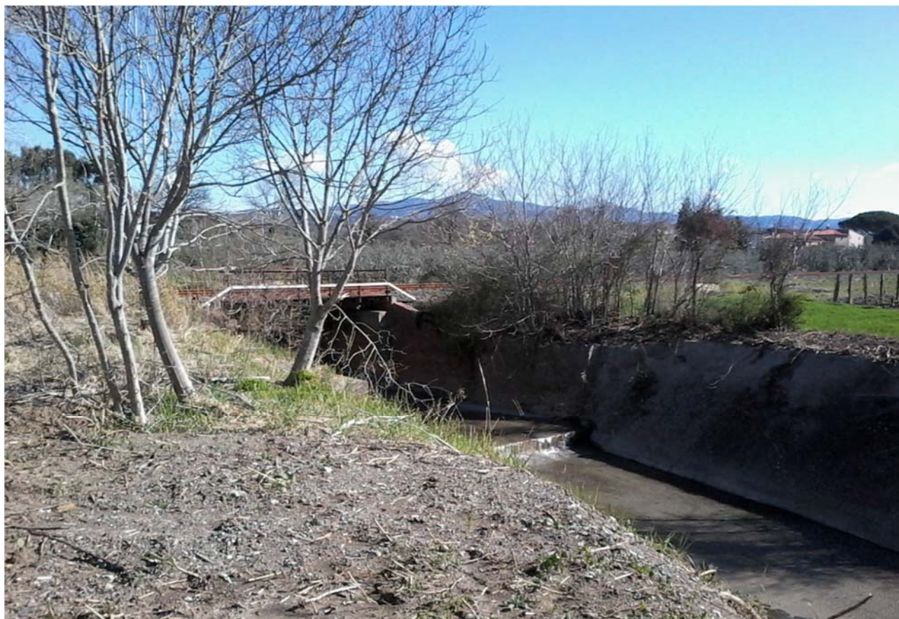
Figura 7- Vista prospetto lato valle
