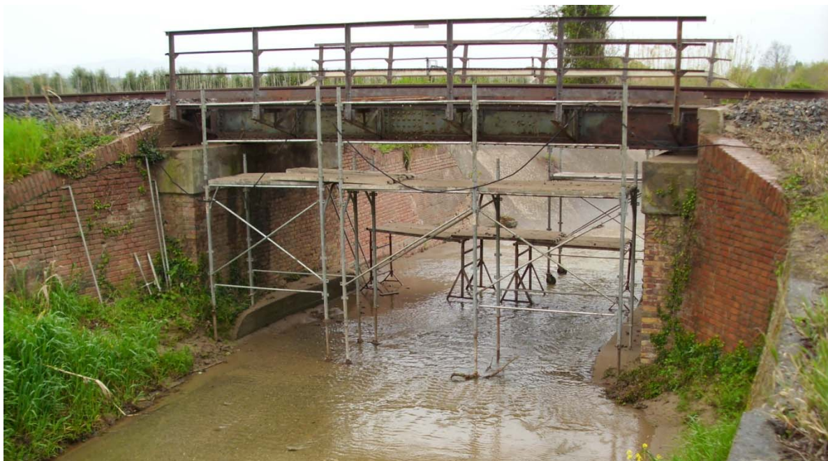
Figura 1 Vista del ponte lato valle
