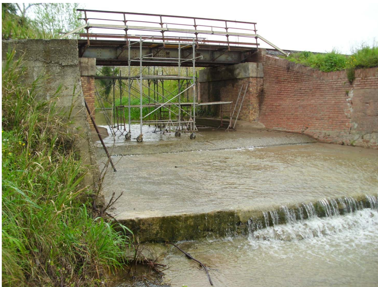
Figura 8 – Stato di fatto spalla lato Volterra
