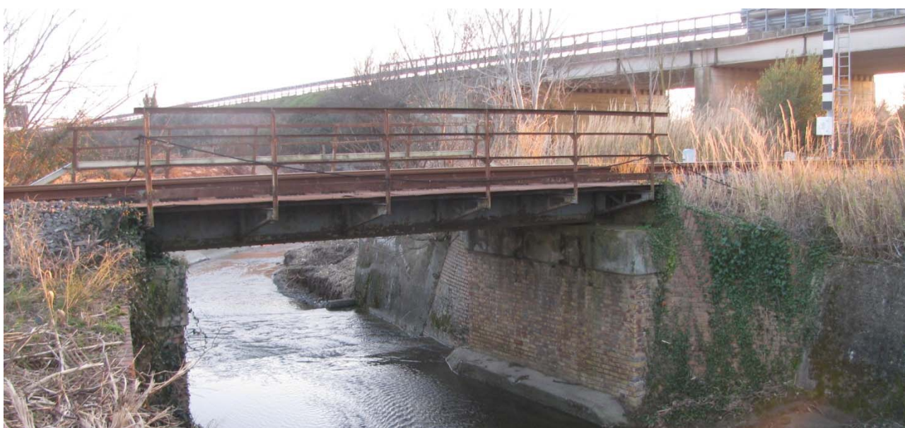
Figura 2.1 Vista del ponte
