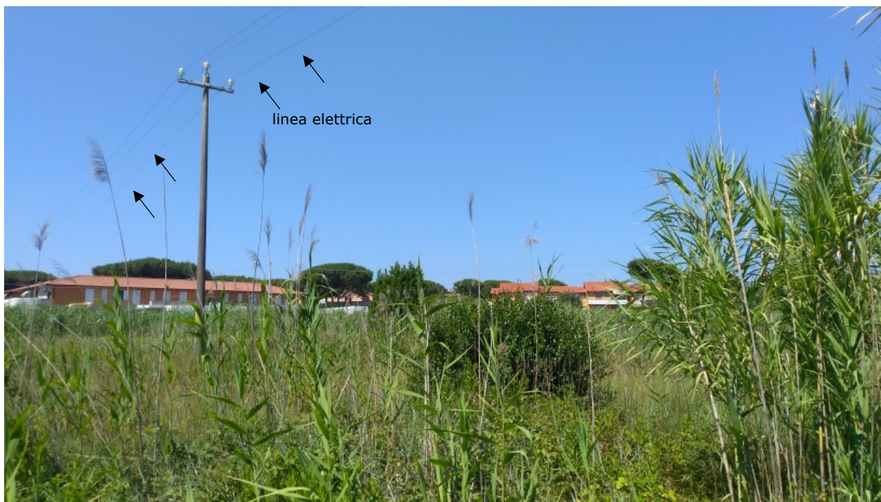
Fig. 9: Vista dall'interno dell'area del CdR verso Via Ferrucci – Particolare presenza linea elettrica
