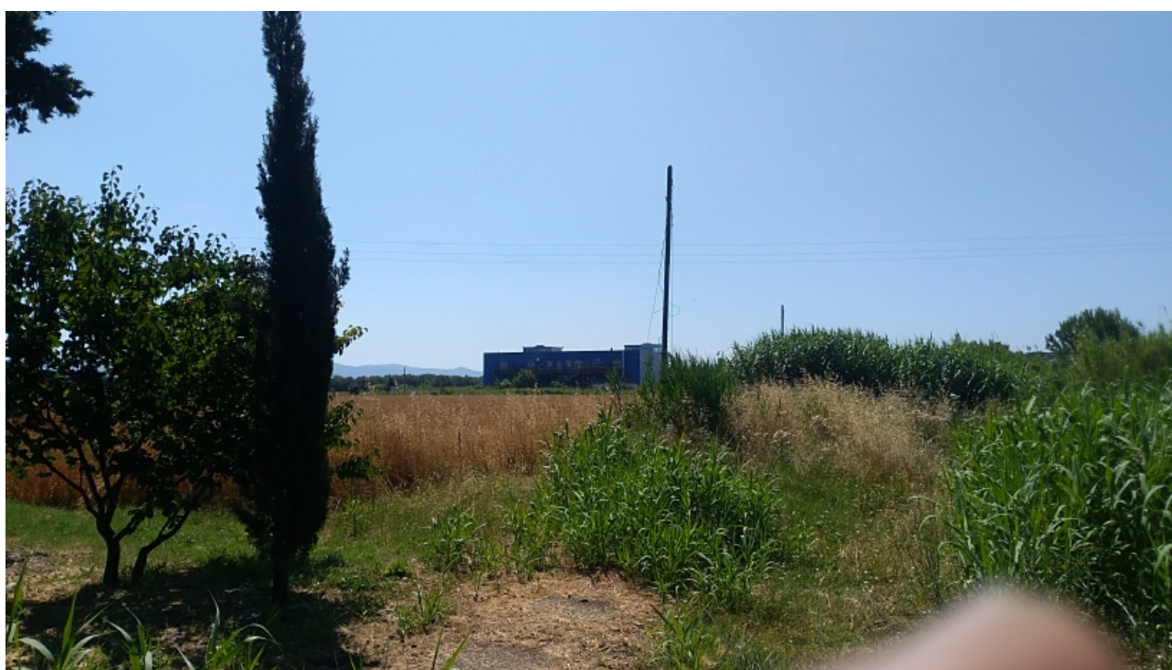
Fig. 2: Vista dall'interno dell'area del CdR verso sud
