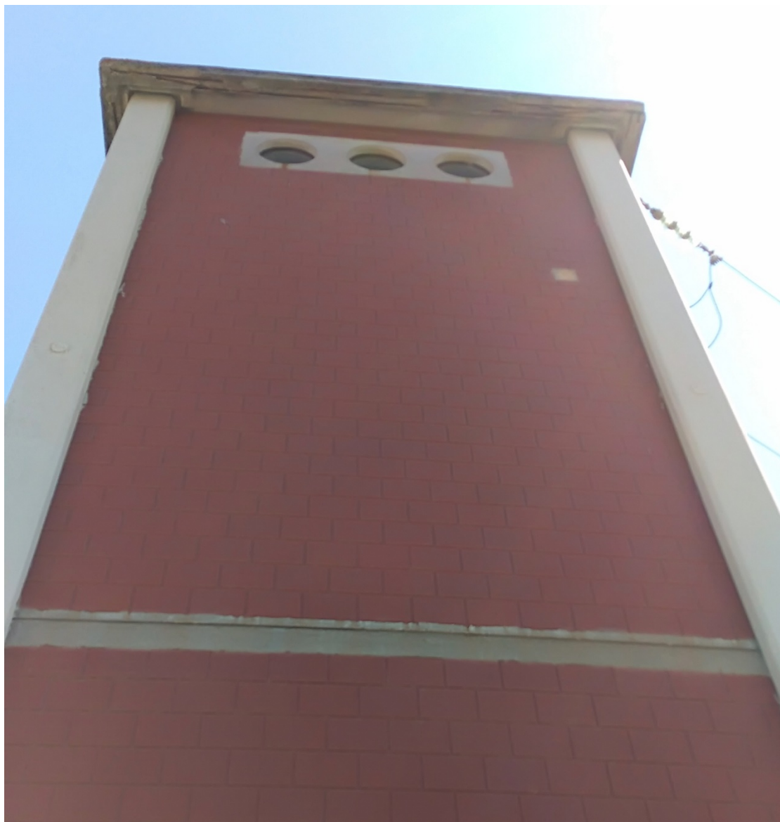
Fig. 20: Vista della cabina di trasformazione all'interno dell'area condominiale dietro l'area a parcheggio
