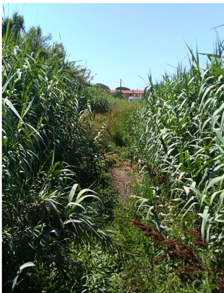
Fot. 36: Vista fosso "Il Gorile" dal ponticello sulla Via del Paduletto verso sud
