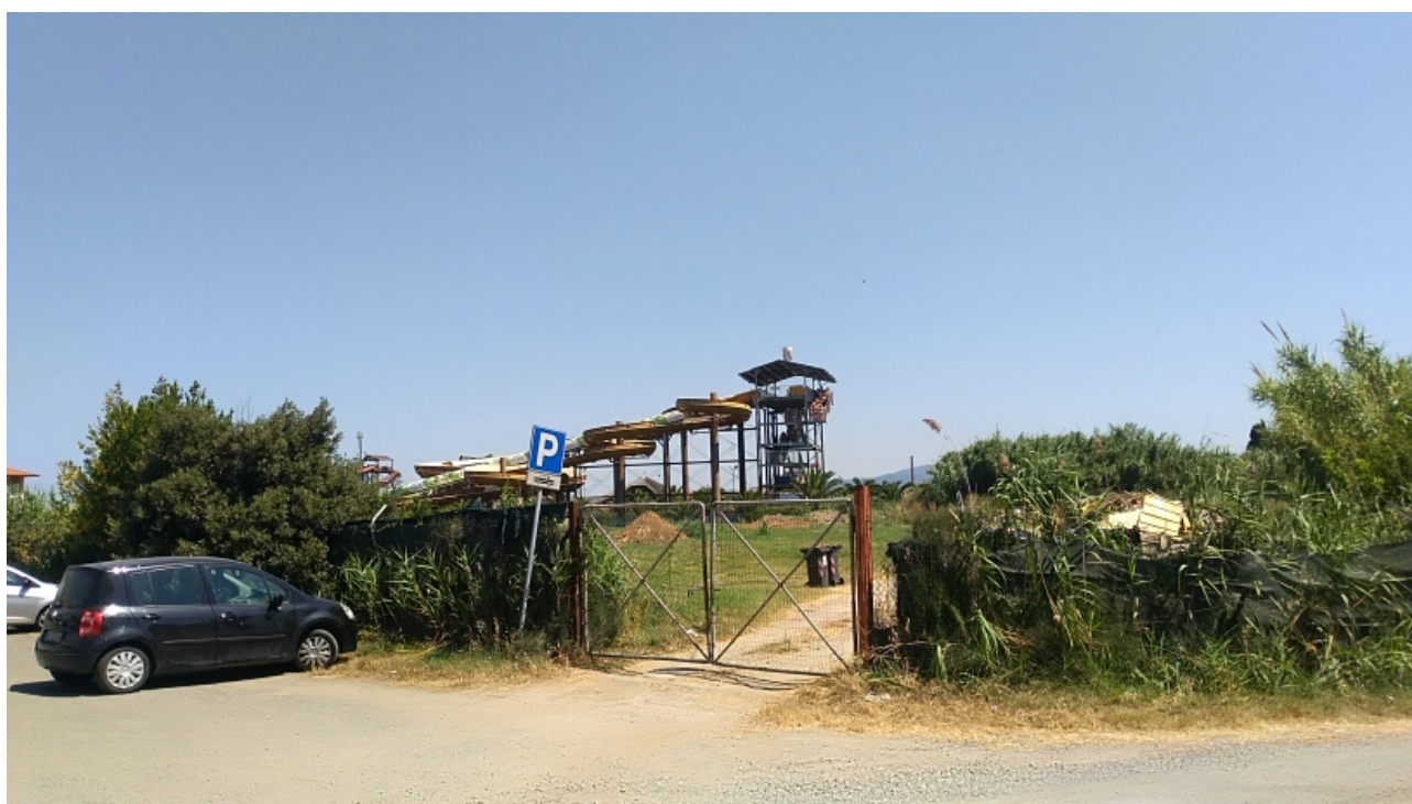
Fig. 24: Vista ingresso di servizio dell'Acqua Park da Via Ferrucci
