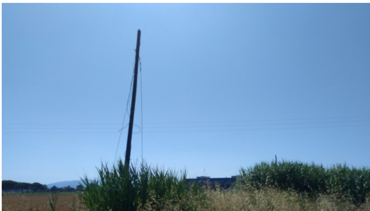
Fig. 4: Vista dall'interno dell'area del CdR verso sud
