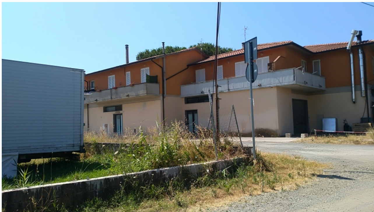
Fig. 17: Particolare delle case dietro l'area a parcheggio
