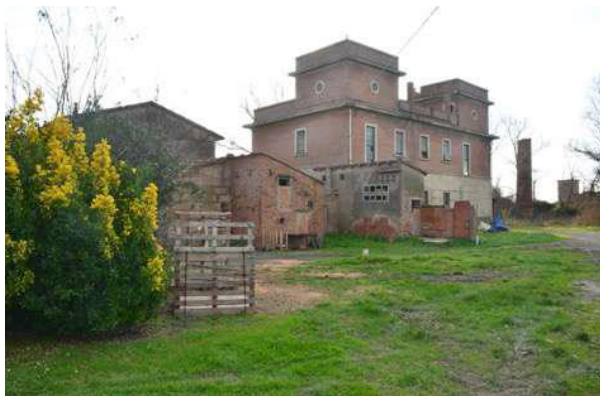
Figura 10: veduta da nord del complesso ex uffici
