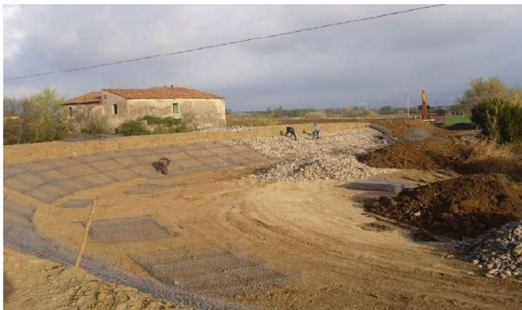
Figura 46: lavori di messa in sicurezza dell'argine del Cecina
