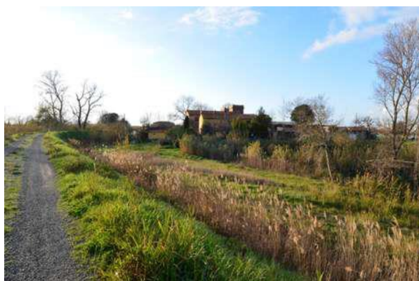
Figura 17: veduta della strada sull'argine remoto realizzato dall'Amministrazione comunale
